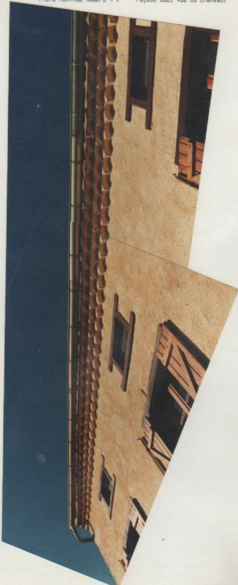
PHOTO-MONTAGE Numéro 4 : Façade sud, vue du chéneau.
