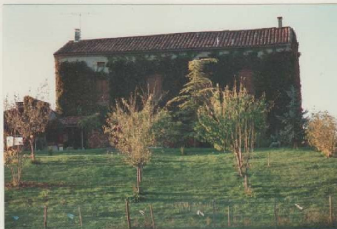
Photographie numéro 21 : Façade Nord vue depuis la position d'observation du témoin, à côté de la zone lumineuse. (objectif 130 mm).
