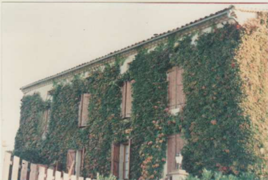
Photographie numéro 13 : Façade Nord vue depuis la route (côté Ouest).
