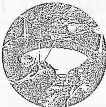
Le radiotélescope d'Arecibo, le plus grand, est fixe et logé dans un creux du sol. Son diamètre est de 300 m. L'antenne collectrice, soutenue par trois câbles, peut être déplacée au voisinage de l'axe principal pour viser des directions différentes.
