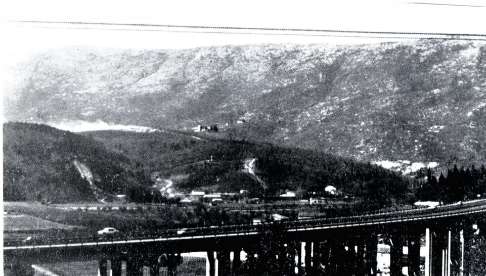
Il teatro delle segnalazioni di Calenzano.
