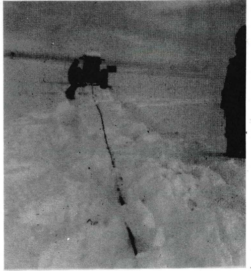
900m kabel blir kjørt ut med traktor.
