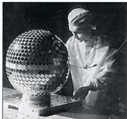
Bildetekst: Starshine 2 er dekket med 845speil som reflekterer sollyset ned på bakken. Siden satellitten roterer, blinker den som en himmelsk diskokule. Foto: Michael A. Savell, Project Starshine.
