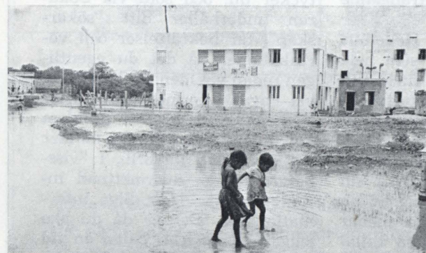
Dräneringen i de nybyggda områdena är ofta otillräcklig; det behövs inte mycket regn för att ge översvämningar.
