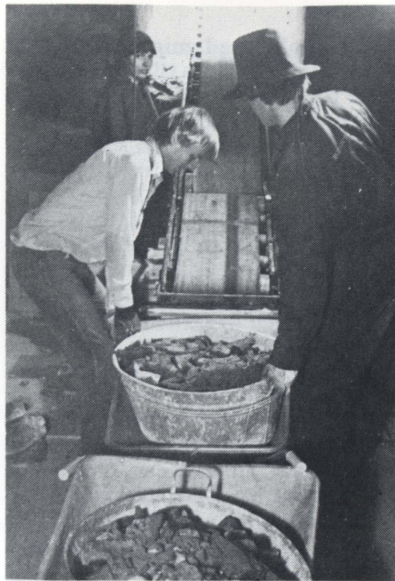
Frivilliga i arbete på Acem-huset i Oslo, en byggnad som rörelsen köpt.
