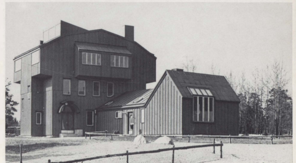
Antroposofisk byggnadsstil. Överst ateljé med bostad samt stora eurytmisalen vid Rudolf Steinerseminariet i Järna. Under biblioteket vid Rudolf Steinerseminariet.
