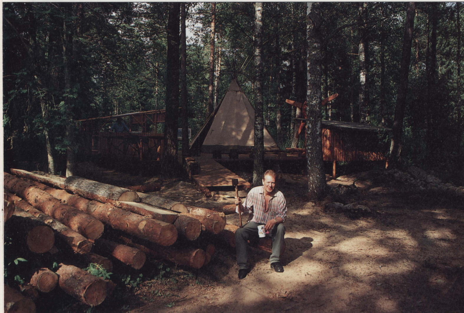
Tre månader har Jan Seilitz slitit med vildmarksbyn. Till hjälp har han haft bröderna Jimmy och Jens Pettersson och sin son Max. 250 liter tjära och 100 liter lacknafta har impregnerat alla stockar. – Ett hästjobb, pustar Jan, men snart drar jag igång med den riktigt stora vildmarksbyn.
