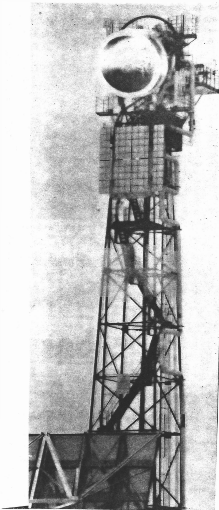
Tornet med mottagaren. Längst ner syns ett av spegelstativen på väg upp ur viloläge. Mitt i mottagaren syns ringen för förvärmning av vattnet som sedan förångas längst fram och leds ner i röret till höger på tornet.
